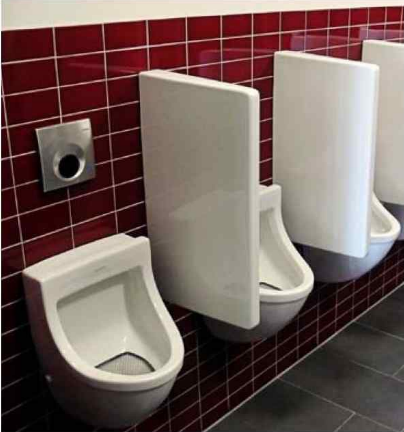
Noch eine ganz normale Toilette: das Männer-WC der Zeche. Im November wird hier die weltweit erste Schwarzwasseranlage installiert.
